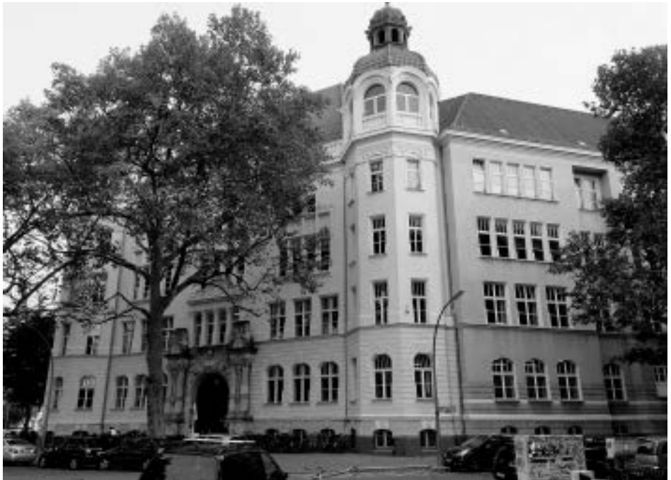
Gebäude der VHS Tempelhof-Schöneberg in Berlin
